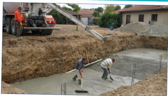
• Dalle lissée en béton armé 15 cm dosée à 350 kg/m<sup>3</sup>.
